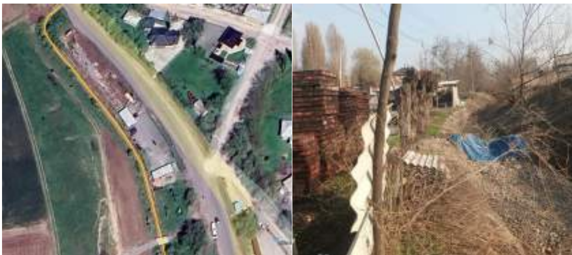
Рисунок 29 Участок канала Присавай с ПК0+80 по ПК6+90
