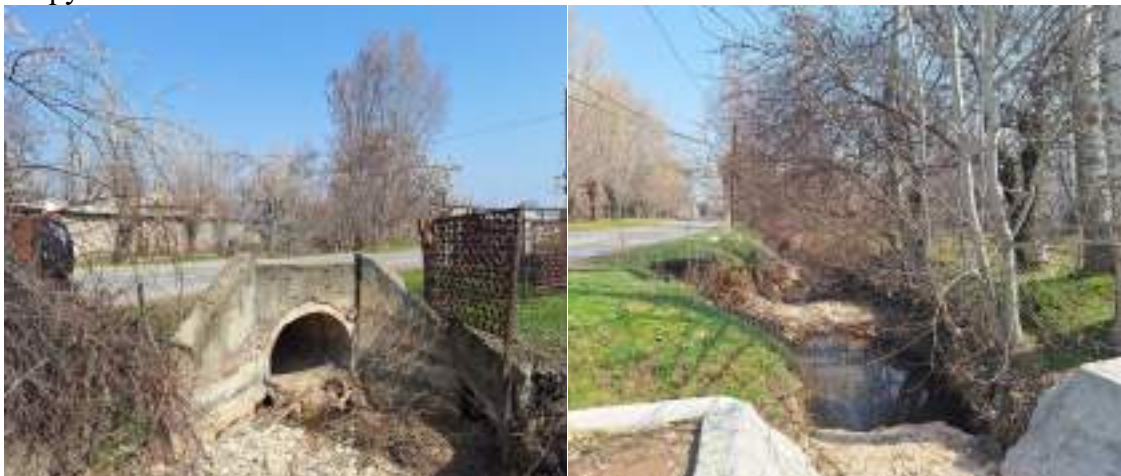
Рисунок 11 Сооружения на канале «Бостон»
