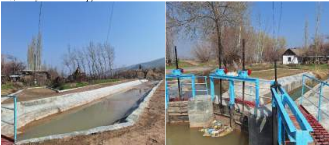
Рисунок 10. Сооружения на канале «Мырза-Куршаб» Межхозяйственный канал «Бостон»
