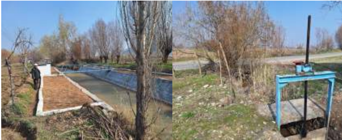
Рисунок 9. Сооружения на канале «Кочкор-Ата» Межхозяйственный канал «Мырза-Куршаб»
