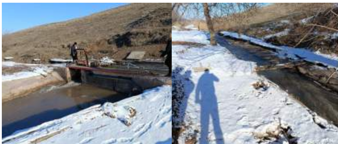
Рисунок 5. Сооружения на канале «Присавай»
