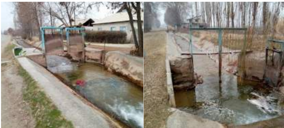
Рисунок 6. Сооружения на канале К-5
