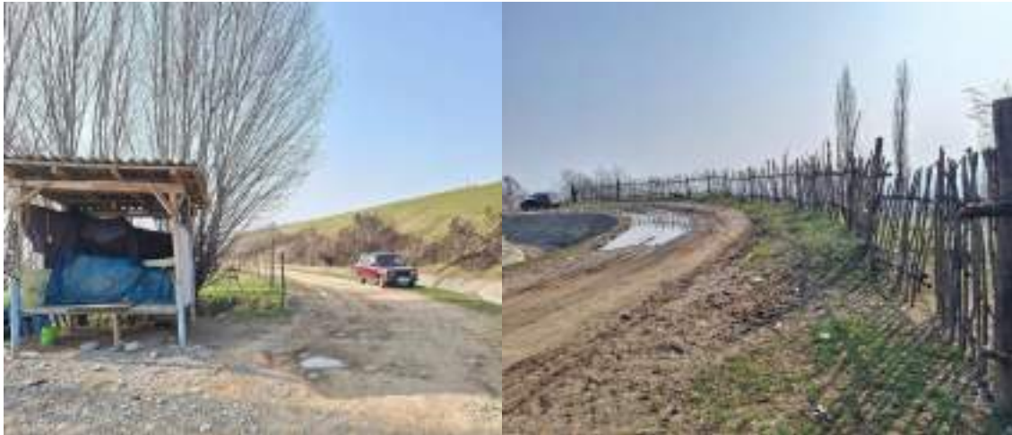
Рисунок 27 Участок канала Обводной с ПК9+14 по ПК11+36
