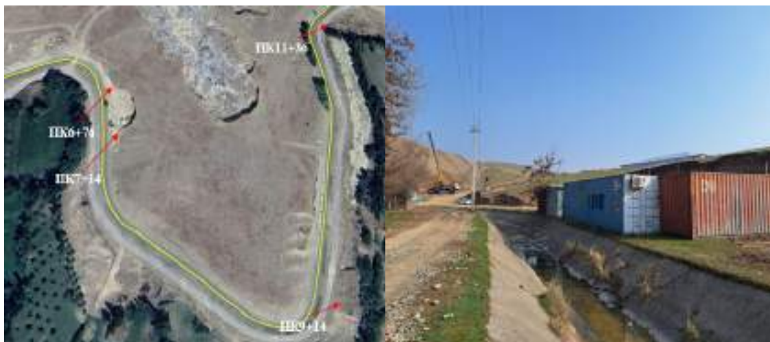
Рисунок 26 Участок канала Обводной с ПК6+76 по ПК7+14
